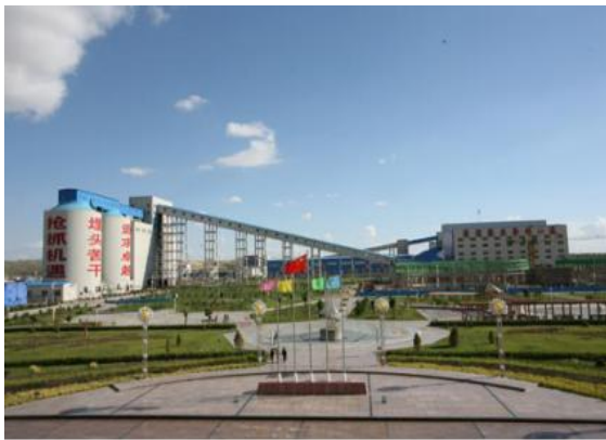
宁夏宁煤枣泉煤矿污水处理厂
