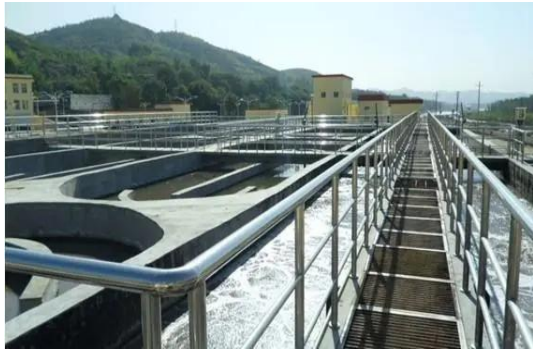
米脂污水处理厂
